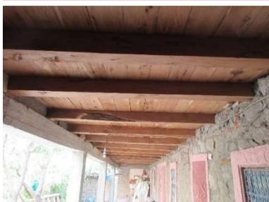
Mise en place d'un planché traditionnel au niveau de la terrasse
