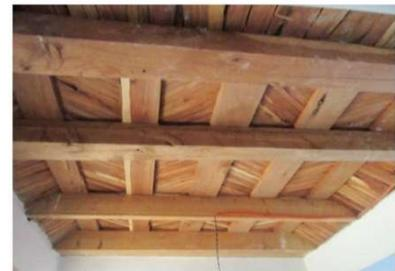
Mise en place d'un plancher traditionnel au niveau de la cuisine
