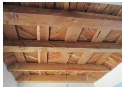
Mise en place d'un plancher traditionnel au niveau de la cuisine
