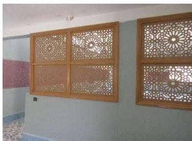
Mise en place d'une cloison de séparation en moucharabieh au niveau du salon
